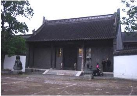
修缮前的泰山庙
